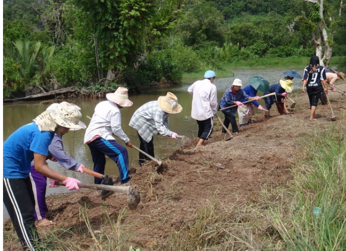
Figura 6: Los aldeanos allanando de nuevo la dique del estanque de camarones para aumentar el área donde los manglares crecerán
