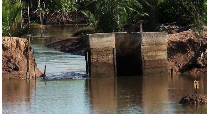
Figura 8: La hidrología es esencial para el éxito de la restauración. El ritmo de drenaje debe ser el mismo en el sitio de restauración como en el manglar natural fuera del estanque. Si el canal tiene una obstrucción en algún punto (aquí, la entrada a un antiguo estanque de camarón), pueden ensanchar excavando (como se hizo aquí al lado de la antigua compuerta) hasta que los ritmos de drenaje se igualen.
